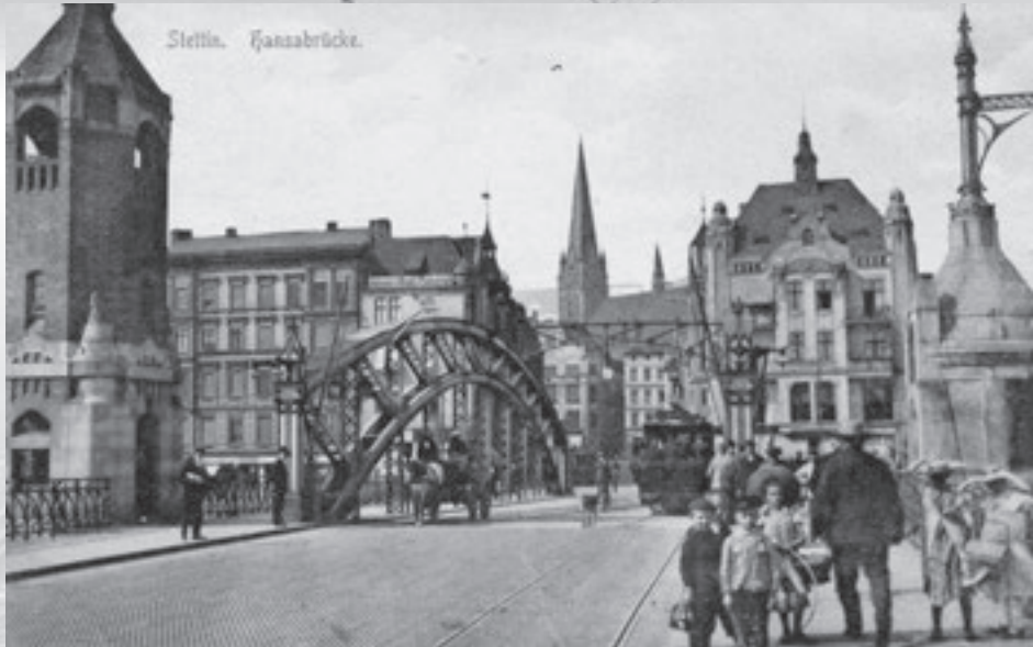
Herbrand (1–92) jako tramwaj linii żółtej (Freihafen – Lindenhofer Weg) – późniejszej linii 1 – na Hansabrücke. Na pierwszym planie widoczna jezdnia przęsła zwodzonego, które tramwaje musiały pokonywać z rozbiegu. Fotografia z ok. 1906 r.
