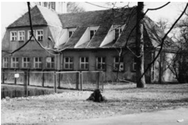
Elewacja zachodnia, 1992 r.
