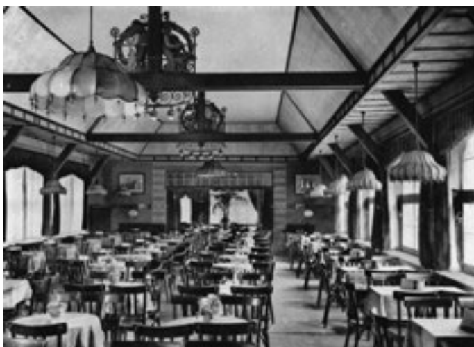
Sala restauracyjna w skrzydle północnym (tzw. hala ogrodowa).
