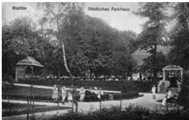
Widok od strony północnej.
