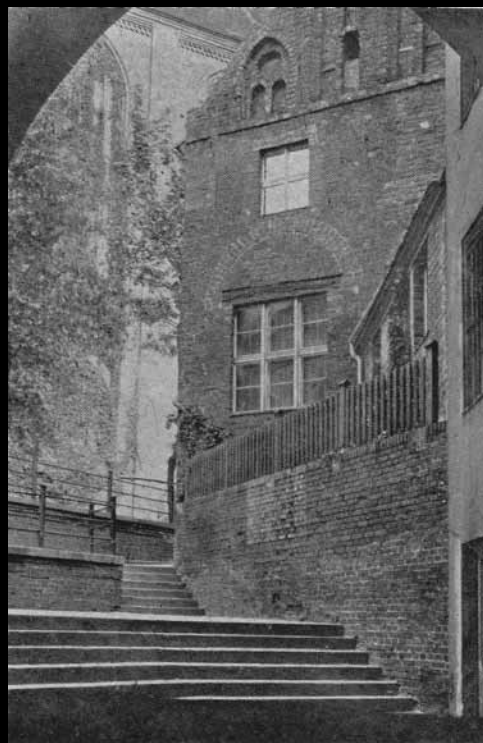
Wyjście z pasażu łączącego Breitestraße z Jakobikirchhof, po prawej stronie dawny Dom Przeora.
